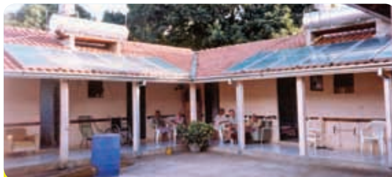
Casa de repouso com aquecimento solar
