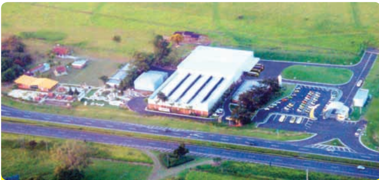
Vista aérea da Soletrol
