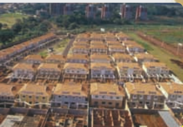
Conjunto Habitacional em Ribeirão Preto - SP
