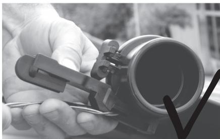
7 - Passe os fios de cobre pelos suportes SLED, no espaço que fica logo abaixo da cabeceira, deixando uma extensão suficiente para que sejam amarrados ao madeiramento do telhado. Comece pelos suportes da cabeceira superior dos coletores e por último os da cabeceira inferior.
