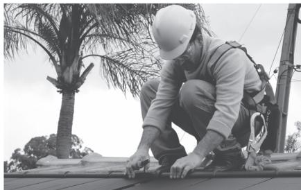
4 - Faça a união dos coletores utilizando os kits CPP. Utilize suportes SLED em todas as uniões feitas nas cabeceiras superiores dos coletores.
